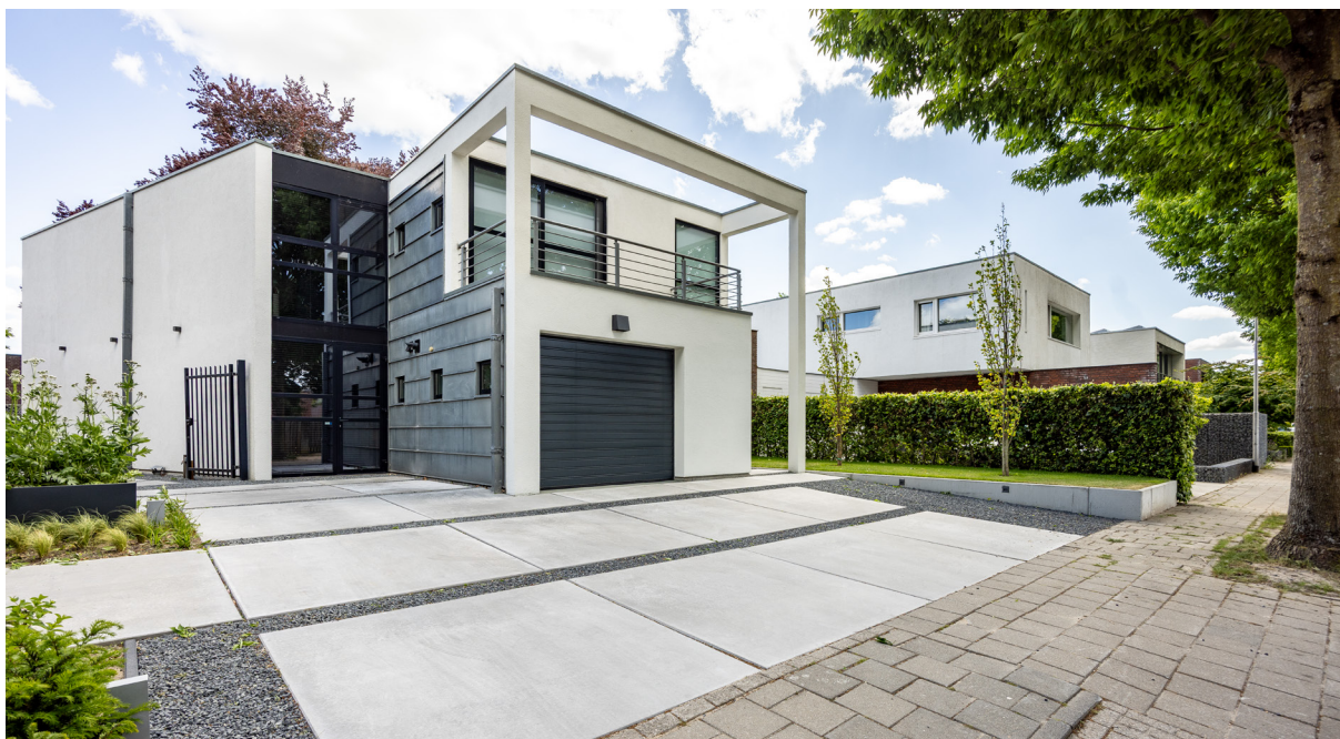
X-Con® Industrieplaten, Woonhuis Udenhout
